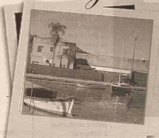
Com a inspeção desativada, o prédio está alugado para terceiros.
